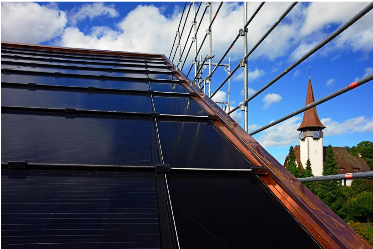
Abbildung 1: Dach des Kirchgemeindehauses Spiez und reformierte Kirche Spiez
