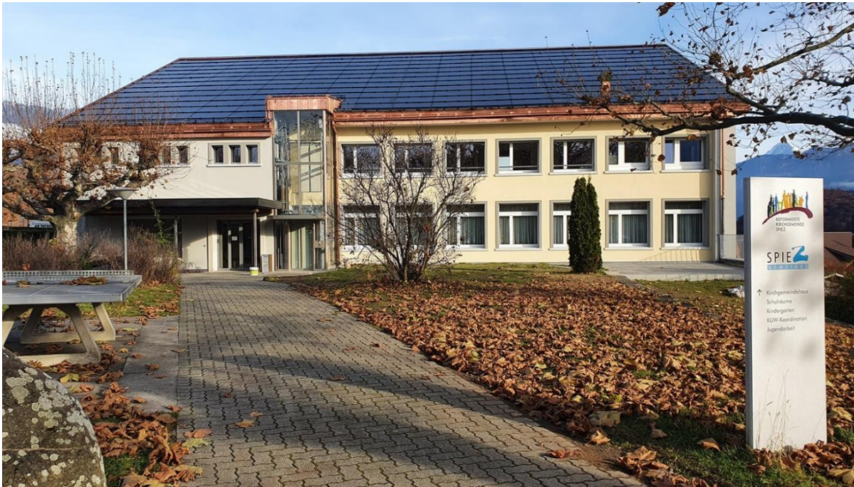
Abbildung 7: Kirchgemeindehaus Spiez mit Photovoltaikanlage
