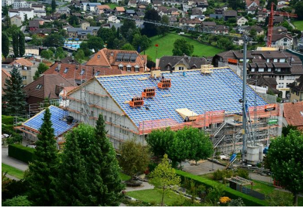
Abbildung 5: Montage Photovoltaikanlage auf dem Kirchgemeindehaus in Spiez
