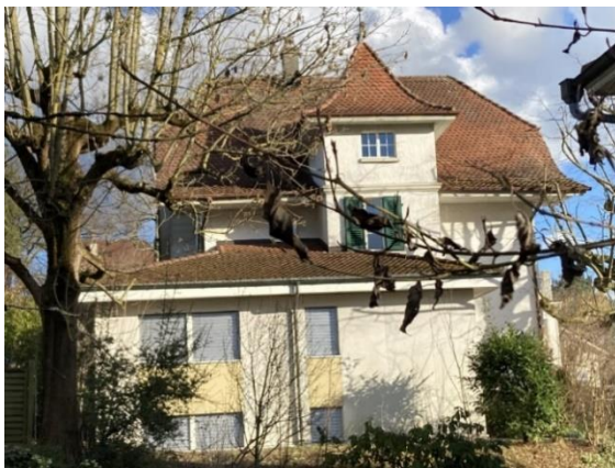
Abbildung 2: Pfarrhaus Ittigen (Sonnenrain 7) vor der Sanierung
