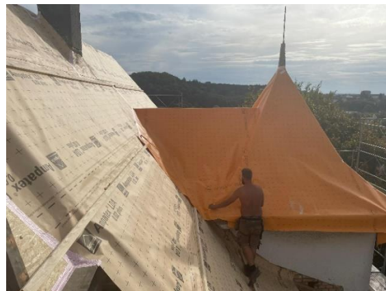
Abbildung 3: Dach des Pfarrhauses Ittigen (Sonnenrain 7) während den Bauarbeiten
