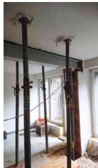
Umbau des Büros für den Informatikdienst.
